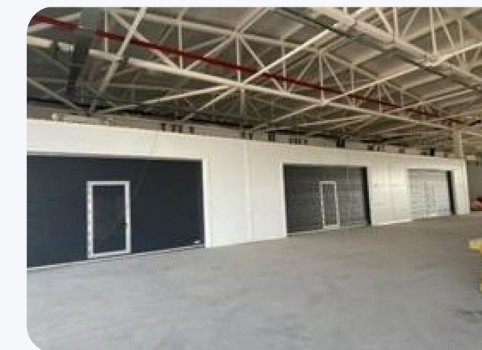
Строительство грузового склада
